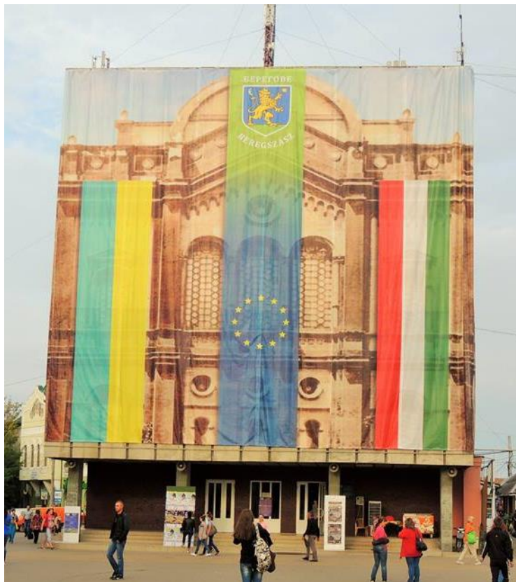
Az egykori zsinagóga Beregszász főterén, jelenleg a város Művelődési Központja
